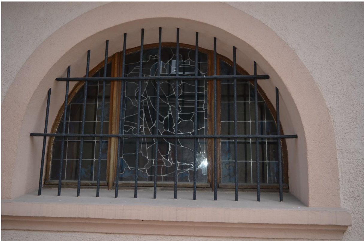
Fot. 9 Okno elewacji północnej wypełnione witrażami.
