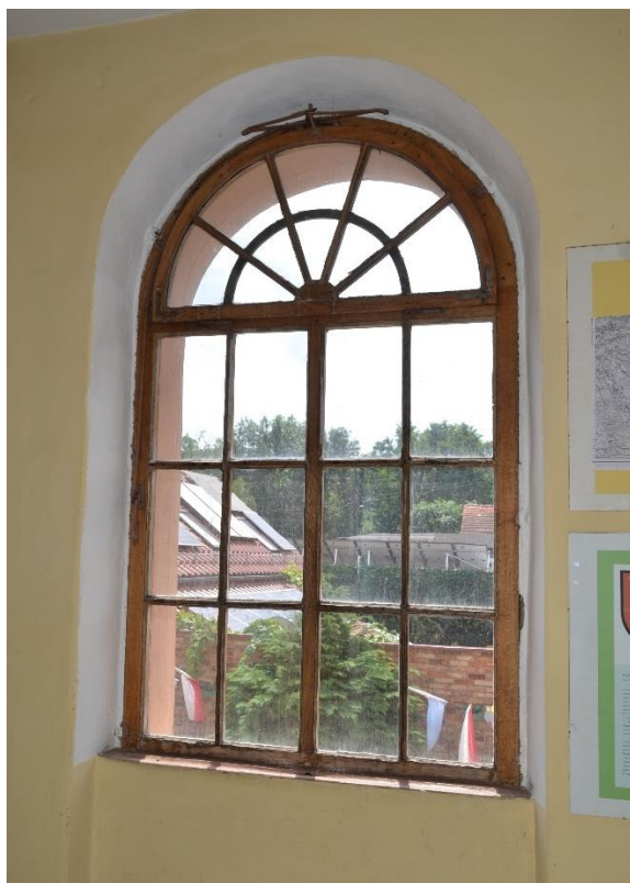
Fot. 5 Okno drugiej kondygnacji elewacji południowej z nadświetleniem ze szczelinami w układzie promienistym – strona wewnętrzna.
