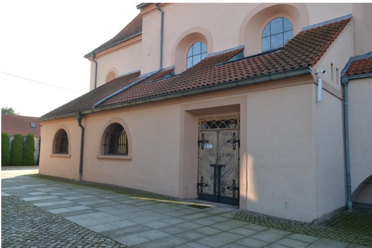
Fot. 8 Część stolarki okiennej i stolarka drzwiowa elewacji północnej.
