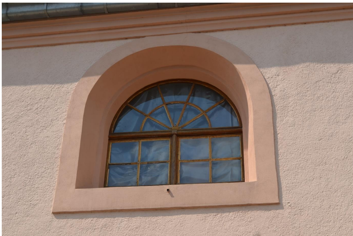
Fot. 2 Okno elewacji południowej, druga kondygnacja.
