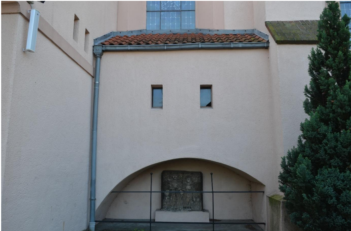
Fot. 11 Drewniane, prostokątne okienka elewacji północnej.
